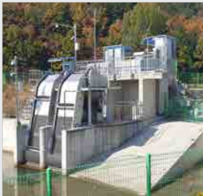
만마지구 자연재해위험 개선지구 정비공사
