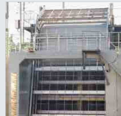
장암지구 상시배수장 설치공사
