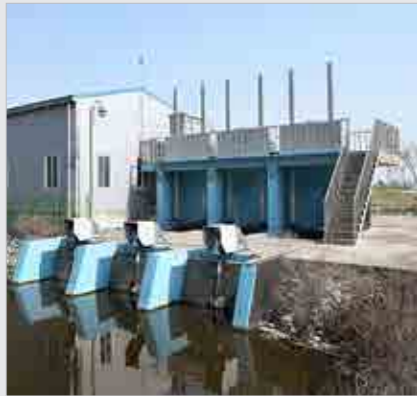
성산 1지구 상습침수지 정비공사
