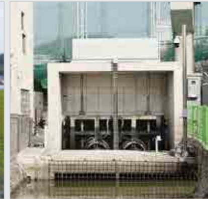
범일동 825-45번지 일원 침수예방 공사
