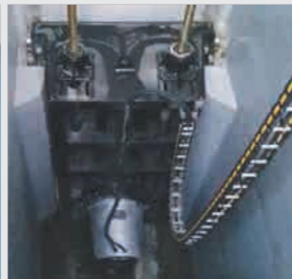
부산 연제구 강제배수시설 설치공사
