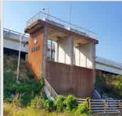
금사지구 하수도정비 중점관리지역 정비사업
