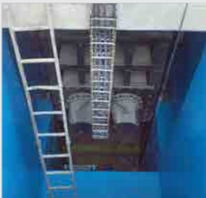
영천하수처리장 고도처리 및 증설공사
