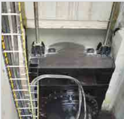
대연3동 송선마을 침수지 해소공사
